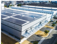
稼働を開始した第10組立工場
