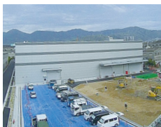
建設中の第3機械工場
