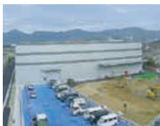
建設中の第3機械工場
