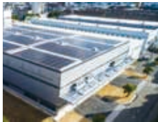
稼働を開始した第10組立工場
