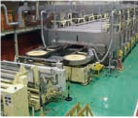
フィルム・シート製造装置
